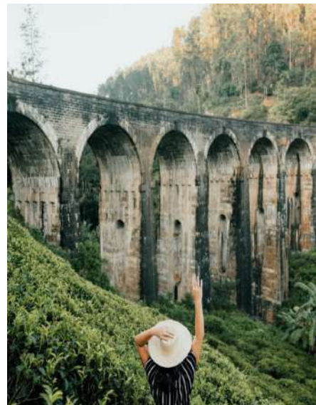
NINE ARCH BRIDGE, ELLA
